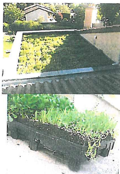
Exemple de toiture-terrasse végétalisée et bacs pré-cultivés
