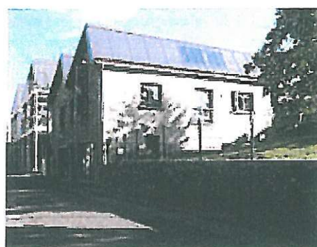
Exemple de toiture en shed
