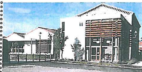
Exemple de lames orientées fixes
